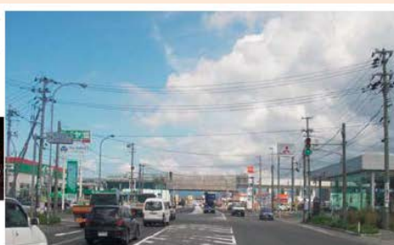
▲国道7号の林立する電柱及び、道路を横断する電線の状況
