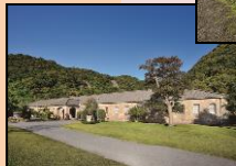
旧集成館機械工場
