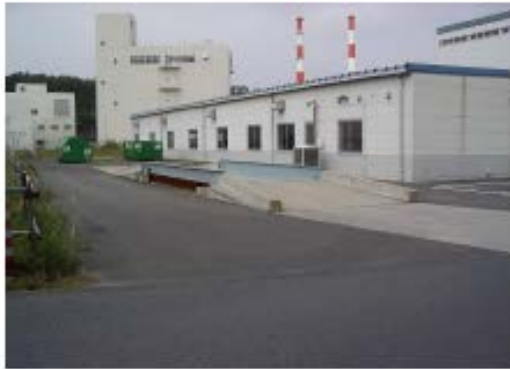
一般器材保管庫の外観
