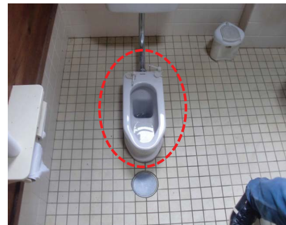
⑥ 便座が破損の幼児用便器(明治の森箕面)
