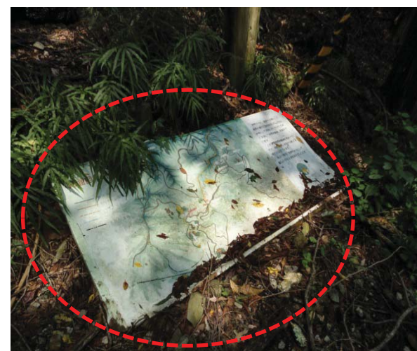
⑨ー i 木枠から外れている案内標識(明治の森箕面)
