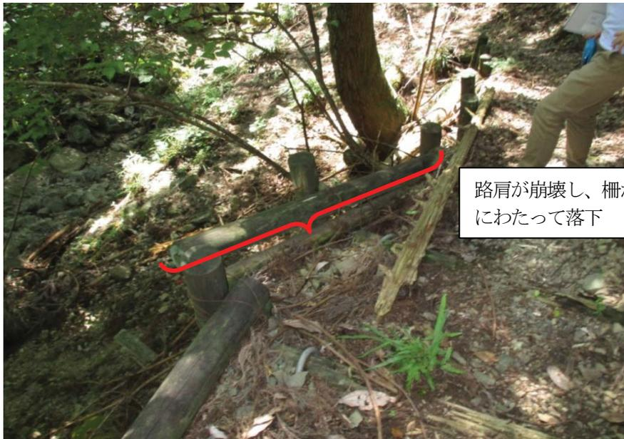
路肩が崩壊し、柵が幅約170cmにわたって落下
