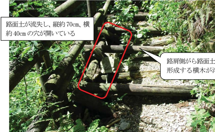
路面土が流失し、縦約70cm、横約40cmの穴が開いている
