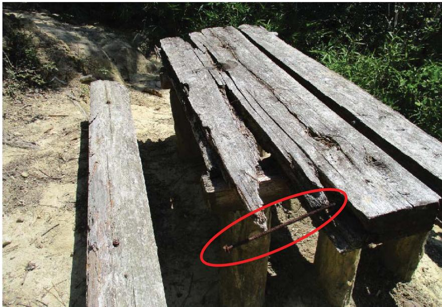
(写真 3 : ベンチの右側は、土台の土が削り取られており、雨などで地盤が緩んだ場合にはベンチごと倒れる危険性がある。)
