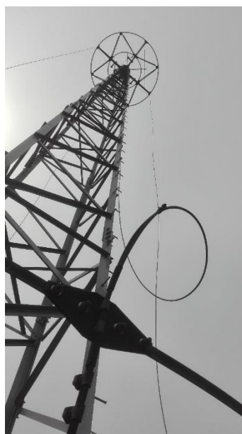
【写真6】 ダウンリード線の外れ
