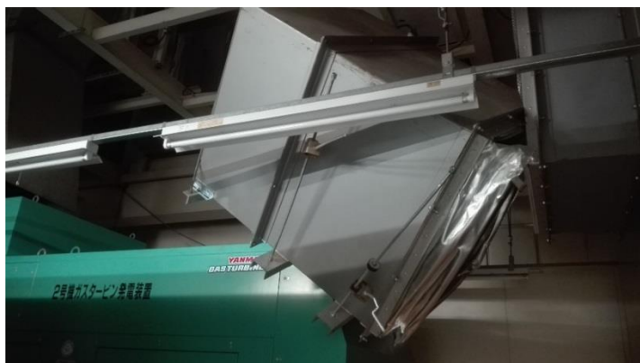
【写真1】 本社8F 発電機吸気ダクト脱落
