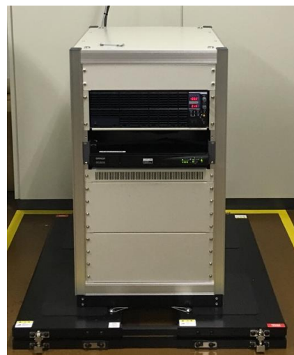
【写真4】震災後、免震台に装置を載せる対策をした。 床の黒い板が免震台。
