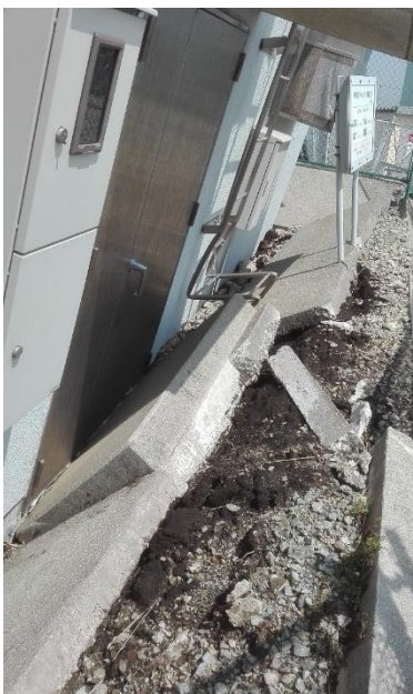
【写真10】 傾いた局舎の正面側
