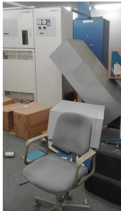
【写真2】 本社8F 電気室の様子
