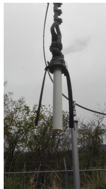
【写真7】 支持碍子の損傷
