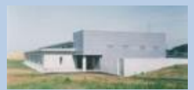
NICT未来ICT研究所(神戸) 第三研究棟
