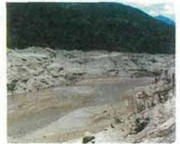
少雨により減水した貯水池
