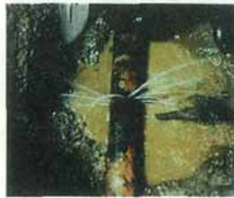
地震により壊れた水道管
