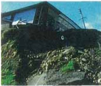
地震により倒壊した建物
