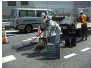
【ポットホールの処理】
