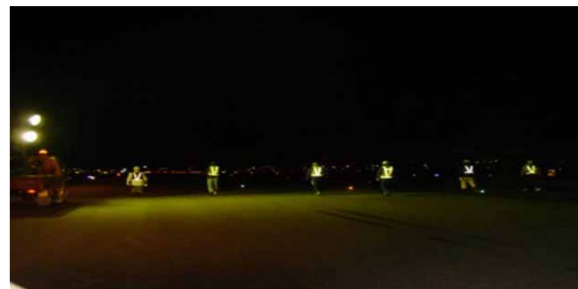
●巡回点検: 滑走路等の不良箇所の有無を調べるために、夜間に点検している。 (施工回数: 舗装の状況で: 全域3回/年、重要区域9回/年)
