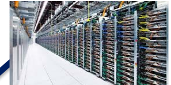
データセンターB
