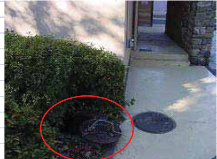
一般トイレ止水栓
