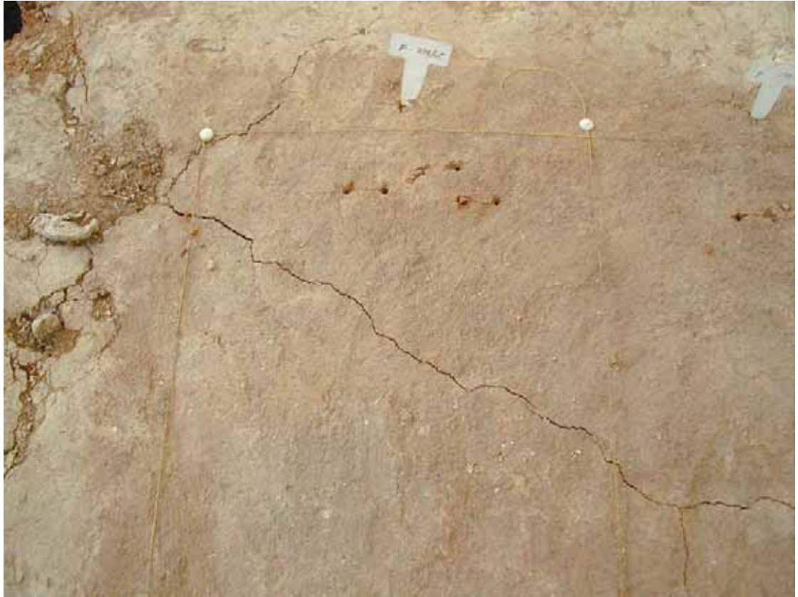
遺構面に発生した亀裂
