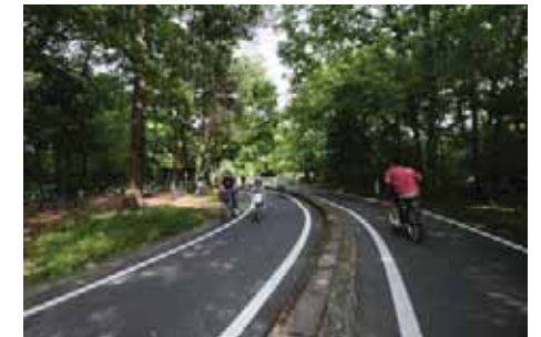
起伏にとんだ全長17kmのサイクリングロード
