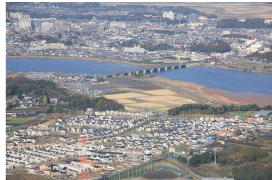
手賀沼 手賀大橋
