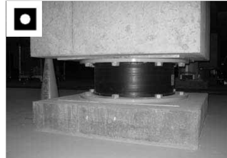
積層ゴムアイソレータ41体 (荷重支持+長周期化)
