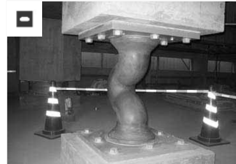
鉛ダンパー16体 (地震エネルギーを熱変換・吸収)
