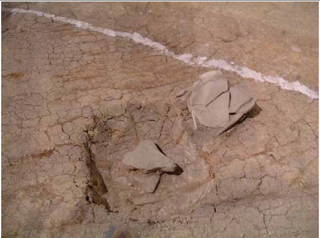
遺構面に発生した亀裂とエッジ部の崩壊
