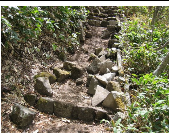
石段が崩壊して歩きにくい状態になっている (切込・刈込湖自然観察教育林)
