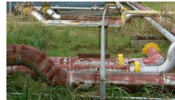
外面が錆びた危険物配管
