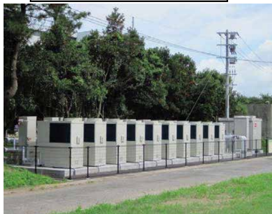
消化ガス発電所全景
