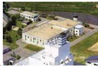
黒石地区清掃施設組合 環境管理センター (昭和58年7月稼働)
