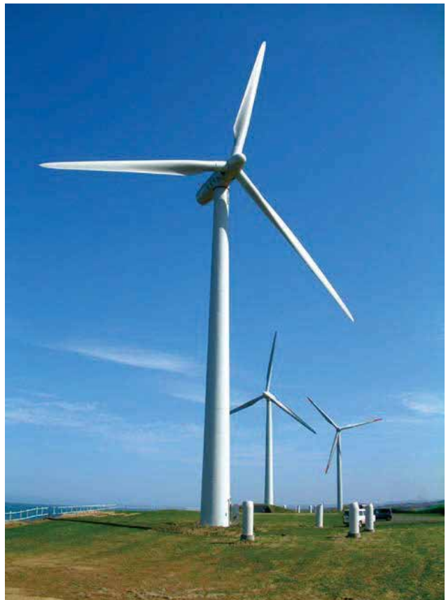
【苫前夕陽ヶ丘風力発電所】
