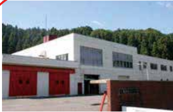
弘前地区環境整備事務組合 中央衛生センター (昭和58年11月稼働)
