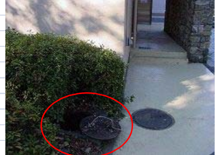
一般トイレ止水栓
