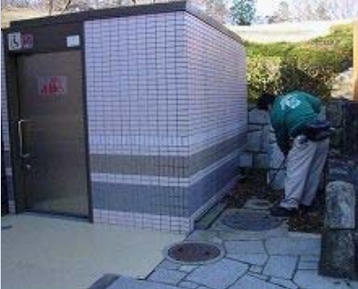
多目的トイレ止水栓
