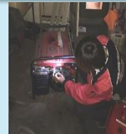
・自家発電機の導入
