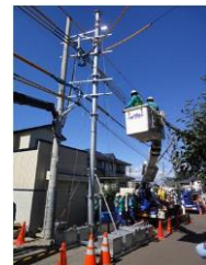
元位置工具新設
