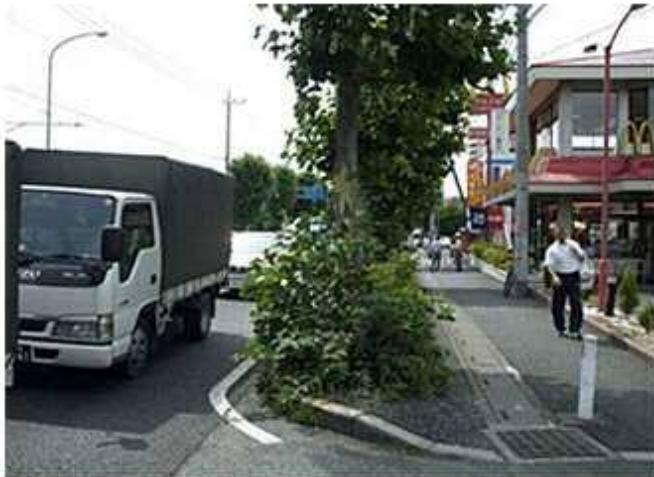
＜急ブレーキ多発個所対策前：国道254号（和光市）＞
