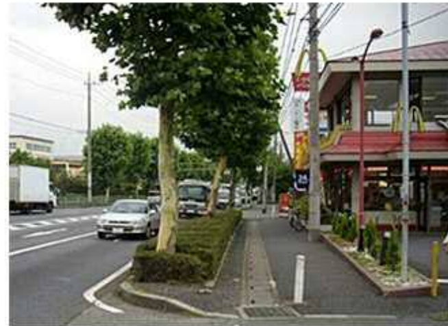
⇒ ＜対策後：街路樹を剪定して見通しを確保＞
