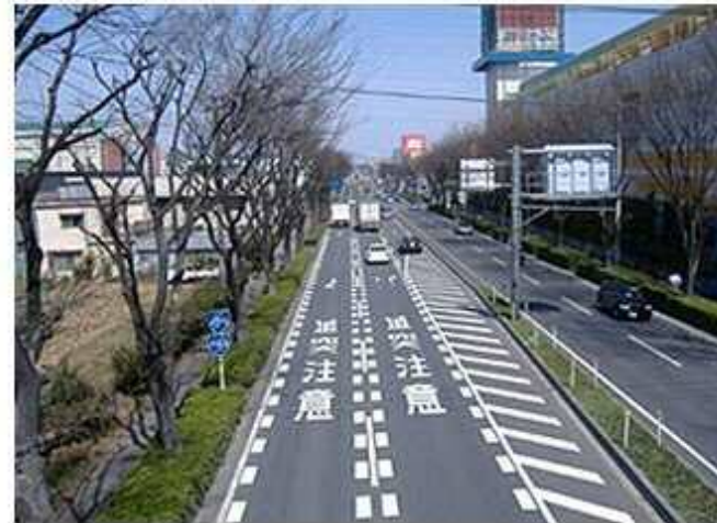
⇒ ＜対策後：路面表示による速度抑制の注意喚起＞
