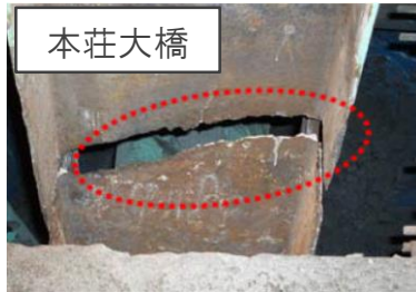
トラス橋の斜材の破断
