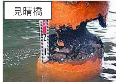
鋼鉄製の支柱の腐食
