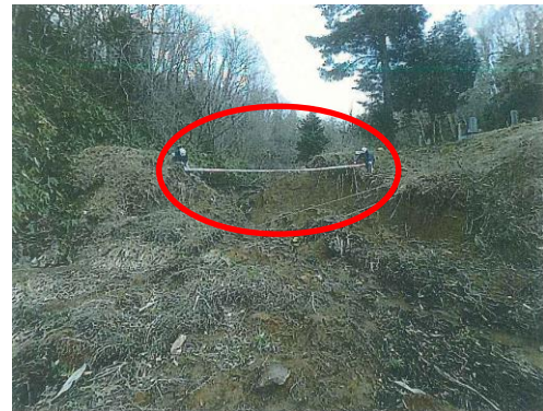
写真２（被災時（復旧前））
