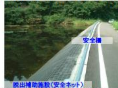
脱出補助施設(安全ネット)
