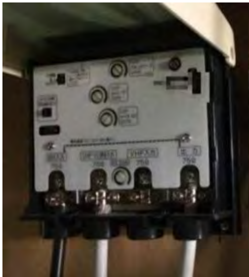
図 3. 6-15 旧式機器『直付け型機器』
