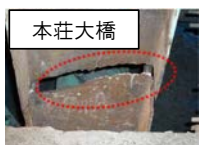
トラス橋の斜材の破断
