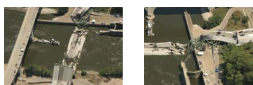
ミネアポリス橋梁の崩壊事故現場
