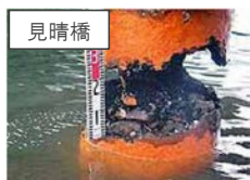
鋼鉄製の支柱の腐食
