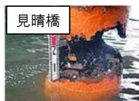
鋼鉄製の支柱の腐食
