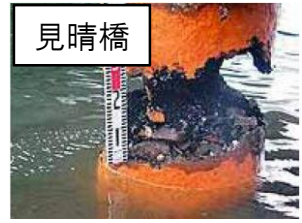
鋼鉄製の支柱の腐食
