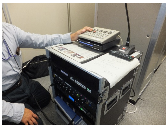
試験電波発射時 熊本市危機管理防災総室・機器室の様子
