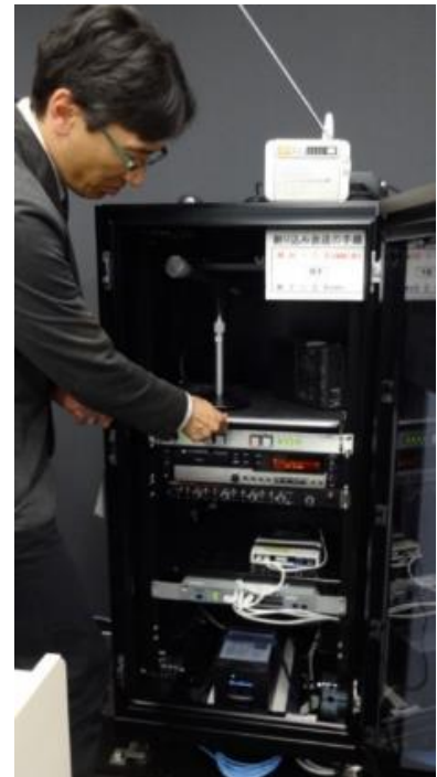
緊急割込リモート装置 (長岡市役所危機管理防災本部)
