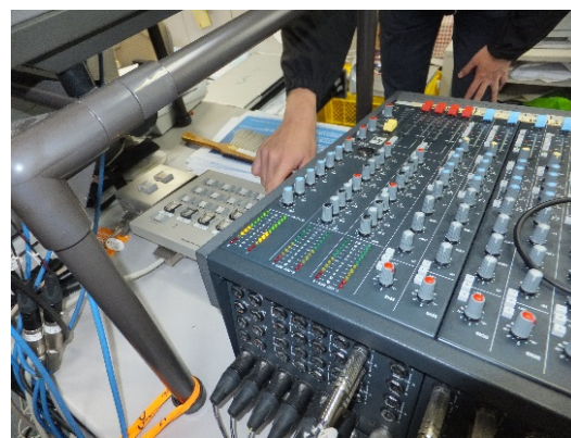
試験電波発射時 (株)熊本シティエフエム・主調整室の様子
