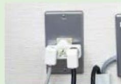
④分配器にテレビケーブルとコネクターを付けた同軸ケーブルを取り付ける
