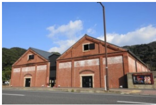
敦賀赤レンガ倉庫
