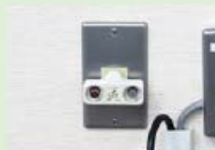
③テレビ端子からテレビケーブルを外し、分配器を取り付ける
