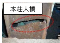
本荘大橋 トラス橋の斜材の破断
