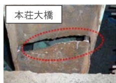
トラス橋の斜材の破断
