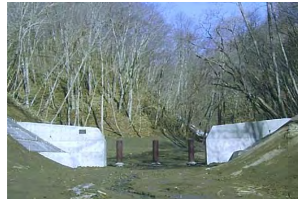
・治山ダム(スリットダム)の例
