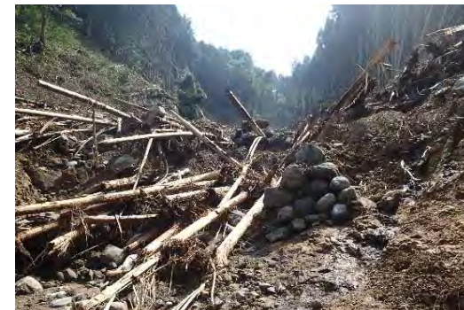
東峰村内の被害の様子
