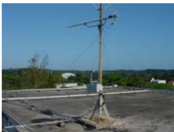
図 9.2.12 5GHz帯FWAの設置状況（小中学校／基地局）
