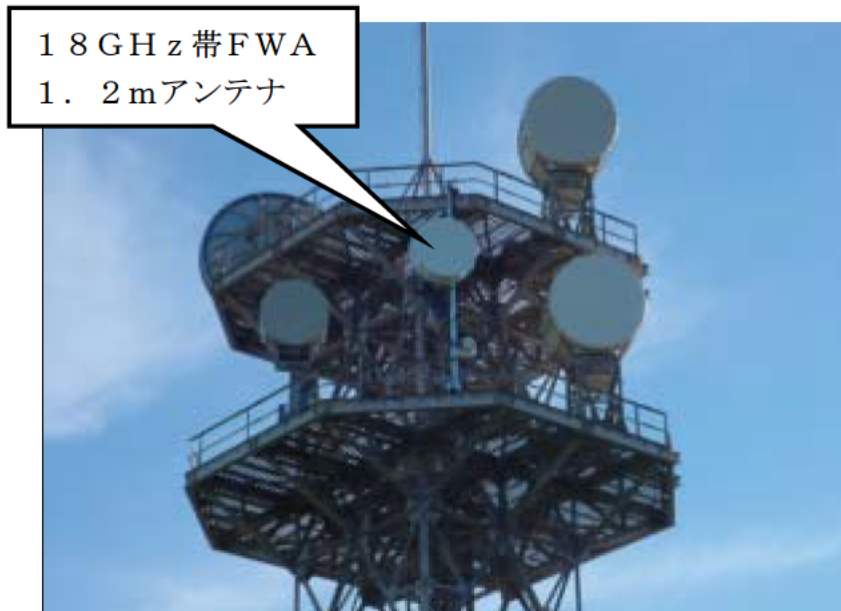
(b) アンテナ設置後
