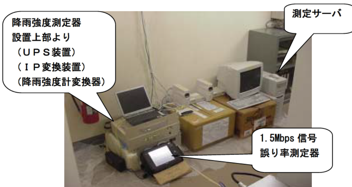
図 2.1.7 測定器材 設置状況
