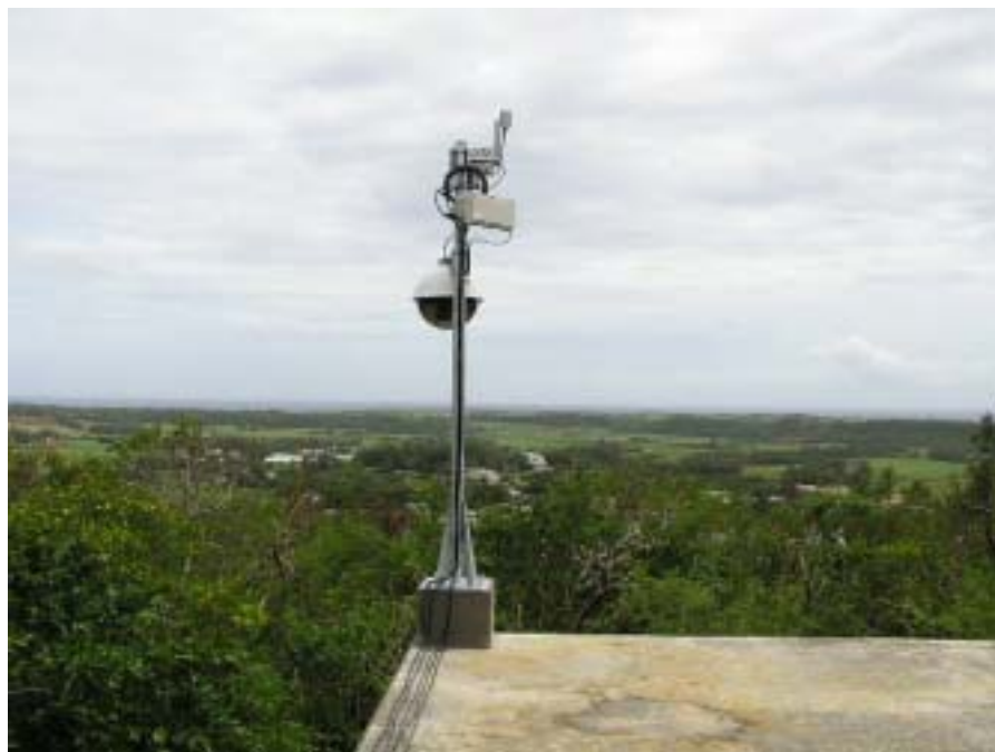
図9.1.12 貯水槽 中継用基地局 設置状況
