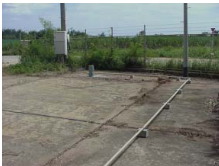
図9.2.5 南大東局降雨強度計 設置状況
