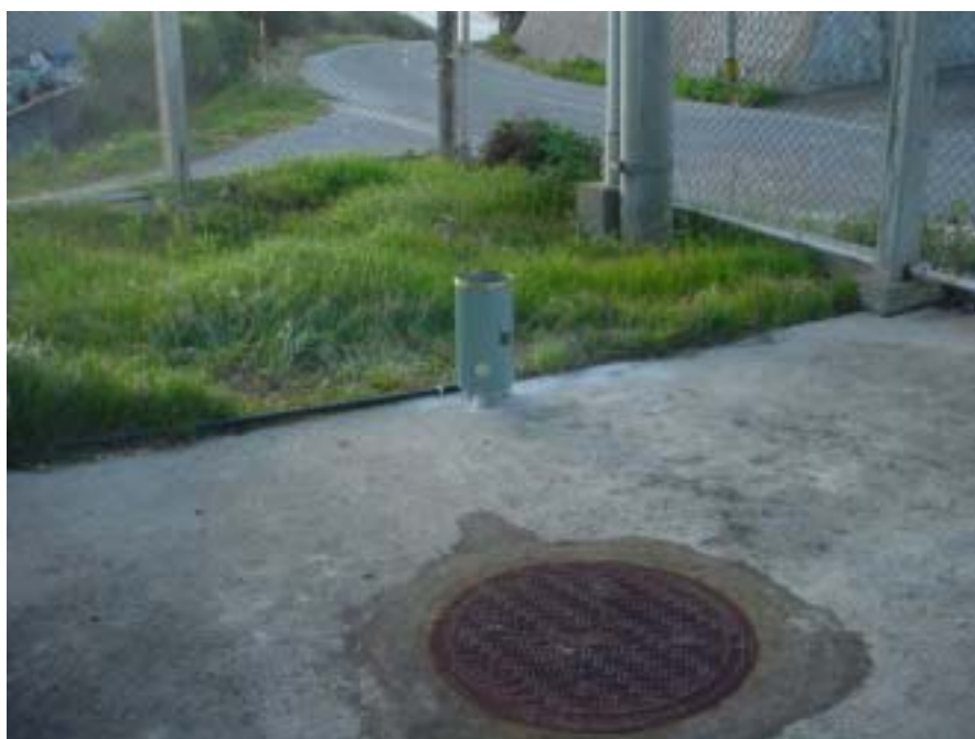
図9.2.10 北大東局 降雨強度計 設置状況
