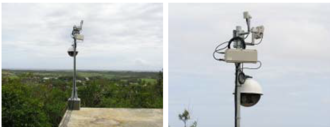
図 9.2.11 5GHz帯FWA設置状況（貯水槽／基地局）
