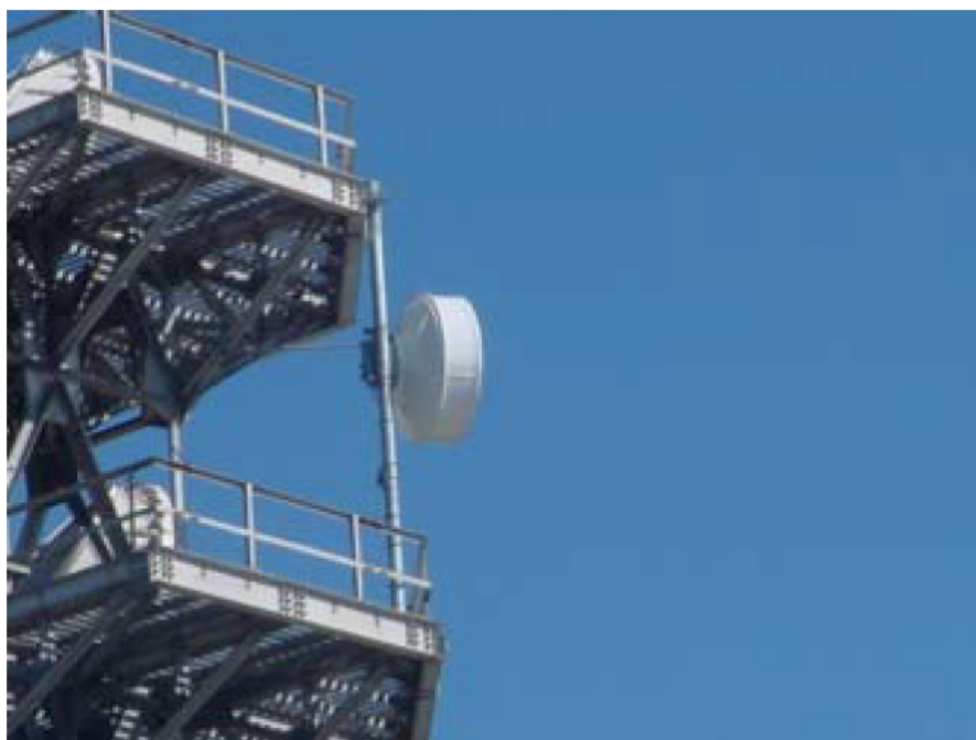
図9.2.7 北大東局 18GHz帯FWAアンテナ設置状況
