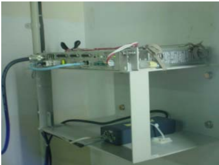
図9.2.9 北大東局 18GHz帯FWA IDU 設置状況
