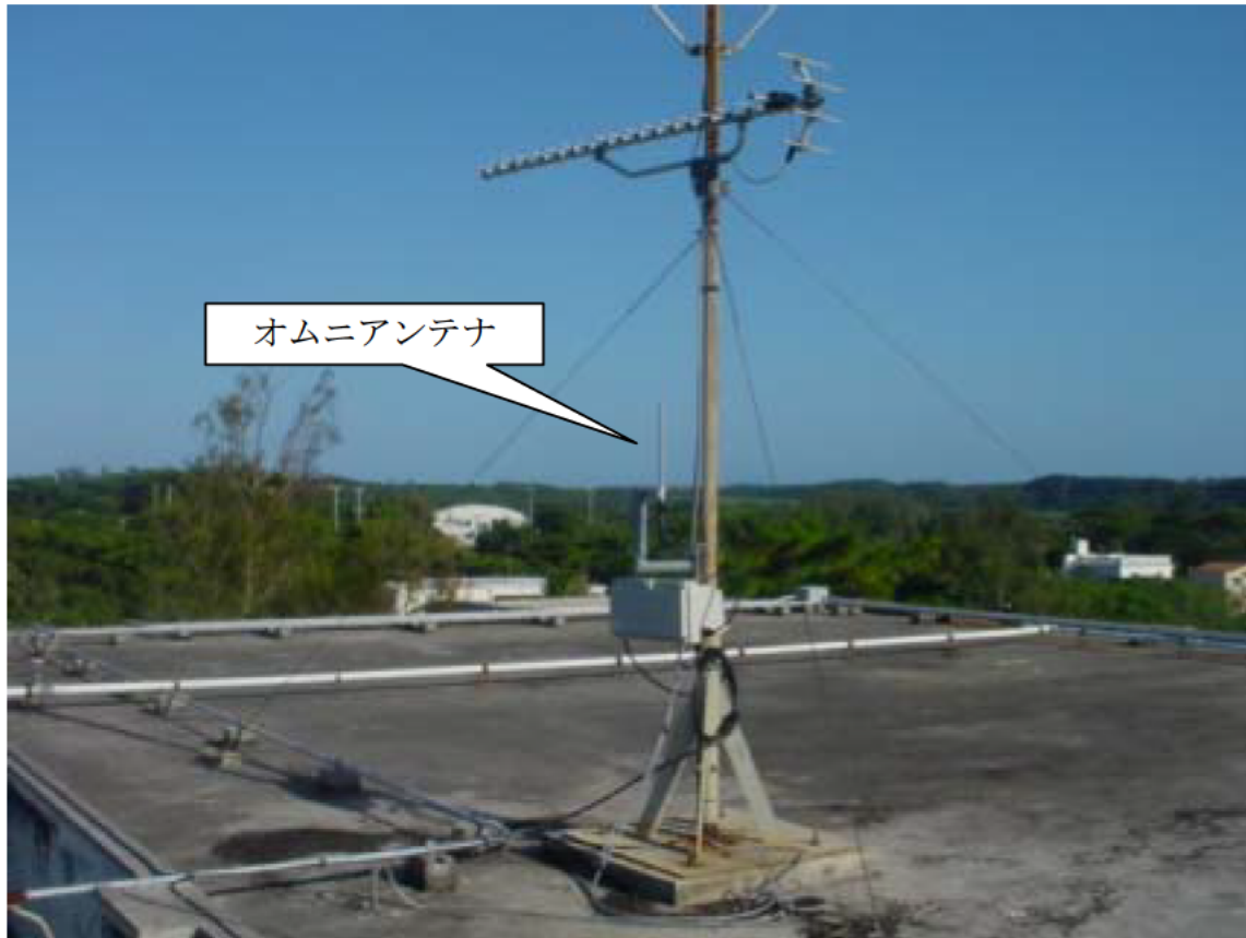
図 9.1.10 北大東小中学校屋上 基地局 設置状況
