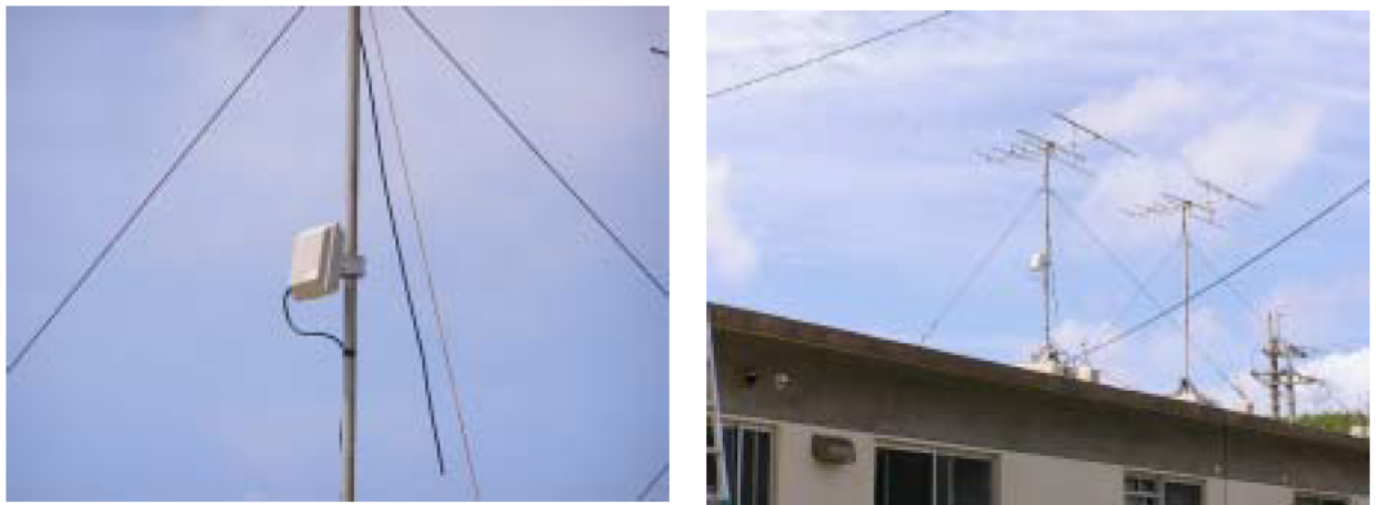
図 9.2.18 職員宅（端末局）の設置状況
