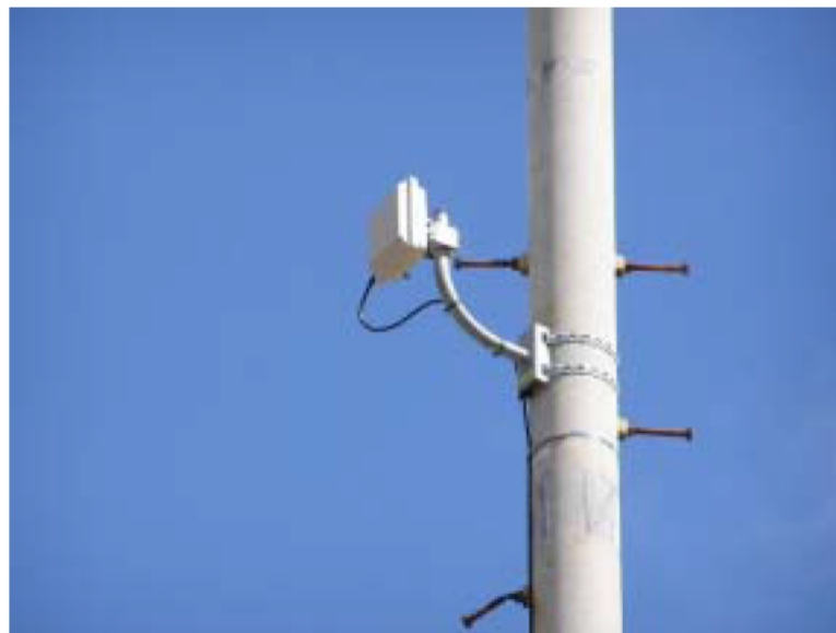
図 9.1.13 セクタアンテナ(指向性：30度)
