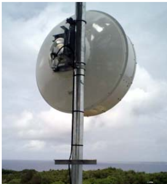
ODU (Outdoor Unit) 及び 1.2m パラボラアンテナ 外観
