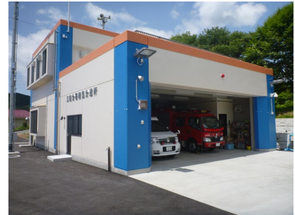
【消防庁舎復旧事業】
