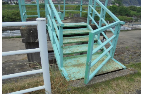
〈入口扉が施錠されていない〉
