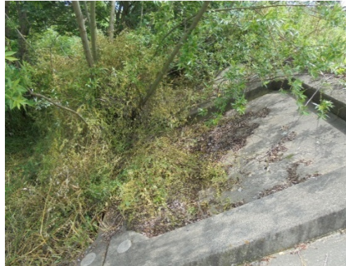
〈護岸に樹木が生えているもの〉
