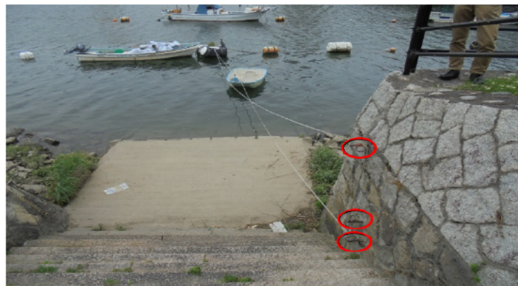
係留ロープ固定のために護岸に打設された鉄製杭【旧太田川】
