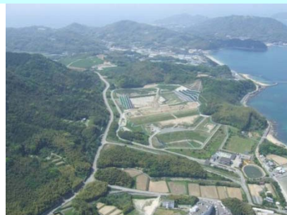
Seibu Landfill Site
