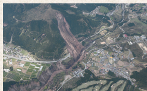
④阿蘇大橋崩落現場
