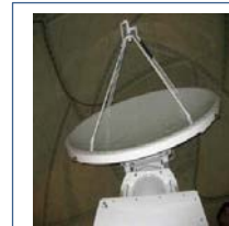
レドーム内のパラボラアンテナ
