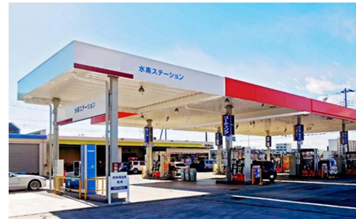
【水素ステーション】
