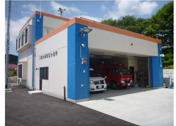
【消防庁舎復旧事業】
