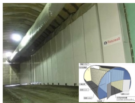
図-5 空間の共鳴を利用したトンネル発破時の低周波音低減（主に 16~63 Hz の発破音を吸音、低減） 7)
