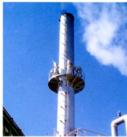
40t/hボイラー
