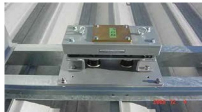
図-18 振動筋の固体伝搬音低減 注釈 1. 動吸振器の設置により建屋壁、屋根から放射されていた低周波音を低減した。 注釈 2. 動吸振器は橋梁の振動低減などにも応用されている。
