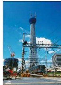
建設中のスカイツリー Tokyo Sky Tree under construction
