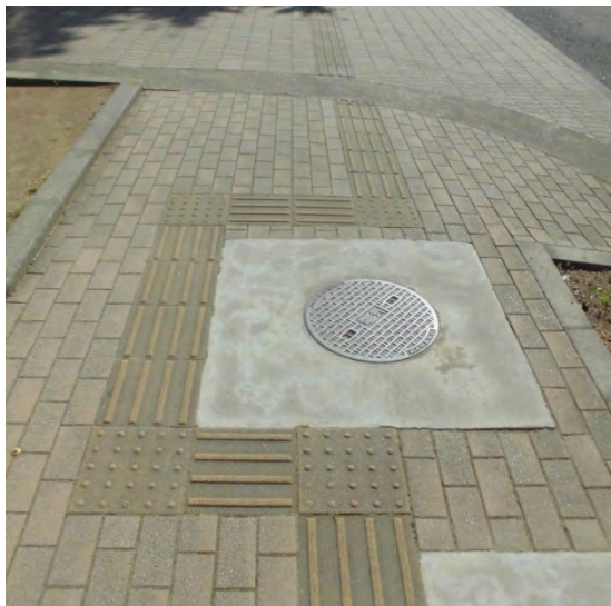
(No. 3) 福井大学 文京キャンパス 工学系1号館1号等前通路
