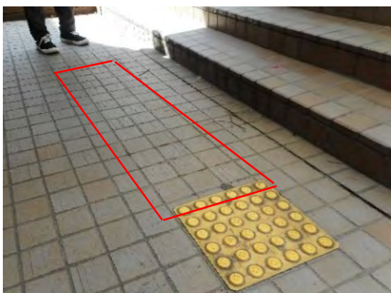
(注) 警告ブロックが1枚を残し大半が剥がれ、機能を果たさない。
