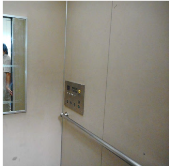
(注) 車椅子使用者向けのエレベーターの操作盤を奥の隅に設置
