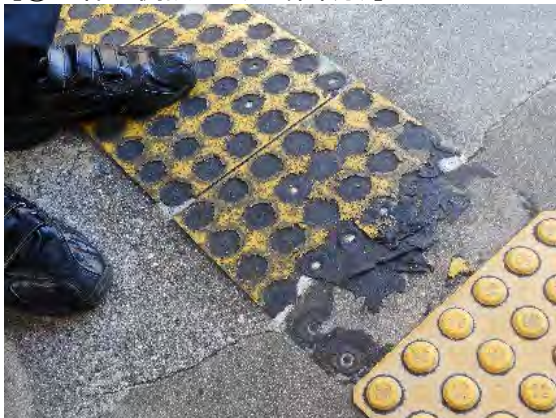
〔③ L棟西側段差（下端部分）〕
