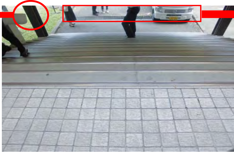
【現地写真】（A棟とF棟の間にある階段）
