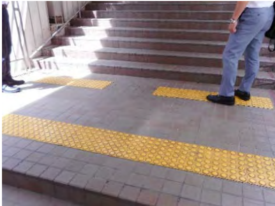
〔① L棟東側階段（踊り場）〕
