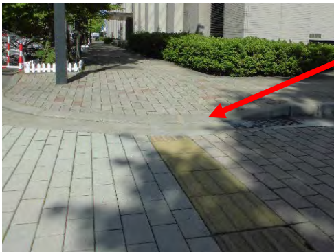
「途切れた」誘導ブロック。道路改修をした際に途切れたのか？敷設の意図が不明
