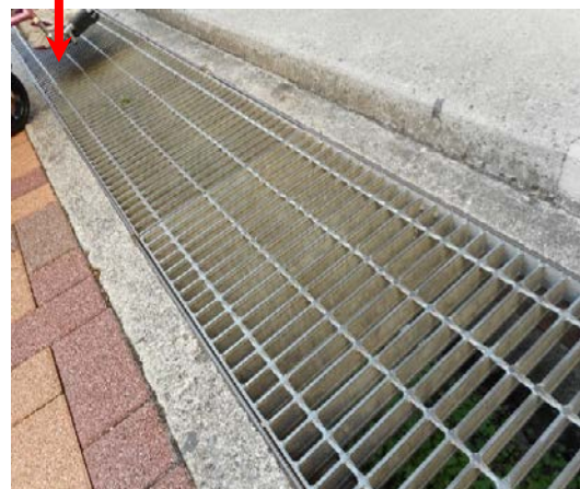
（約9cmの段差（写真の右上）。しかも、手前に格子状の溝ふた。白杖の先端部分がはまり込むおそれ）
