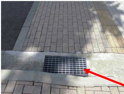
誘導ブロックのすぐ上に、格子状の溝ぶた。白杖の先端や車椅子の車輪がはまりこむおそれ
