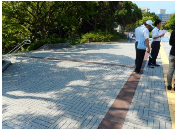
(注) 階段上端から構内歩道に向け、点字ブロック（黄色）なし。
