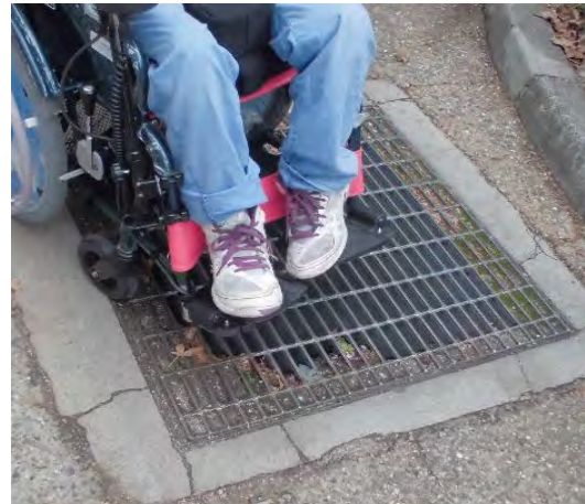
（注） 格子幅が広く（3 cm）、溝の長辺（9 cm）と通路が平行。車椅子の前輪幅が細い場合、はまり込むおそれ
