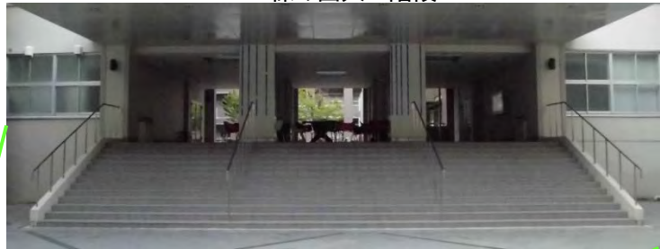
C棟の出入口階段
