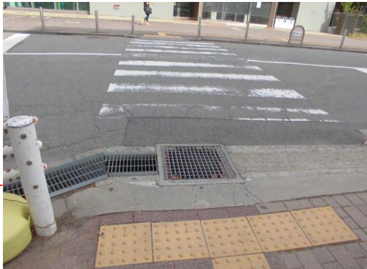
（注）横断歩道のほぼ中央部分に位置する溝ぶた。格子幅が広い。
