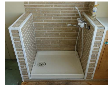
事業所が整備しているウドゥ用設備の例 (株)半谷製作所
