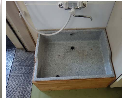
ウドゥ用設備
