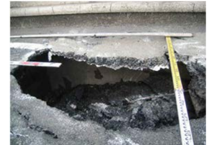
路面の陥没 (出典：首都高速道路株式会社HP)
