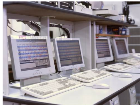
運用監視装置
