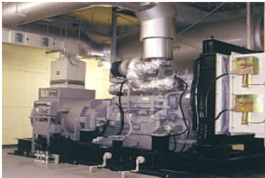
非常用発電機
