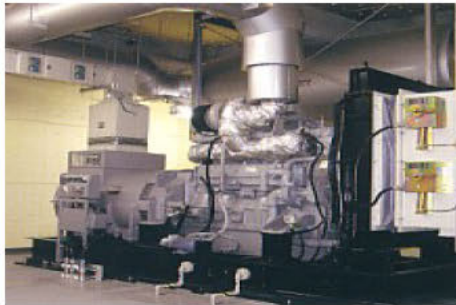
非常用発電機
