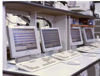
運用監視装置
