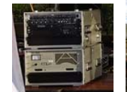
当局が搬入した放送設備
