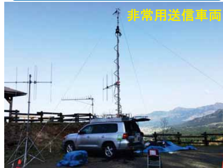
送信所のバックアップ設備
